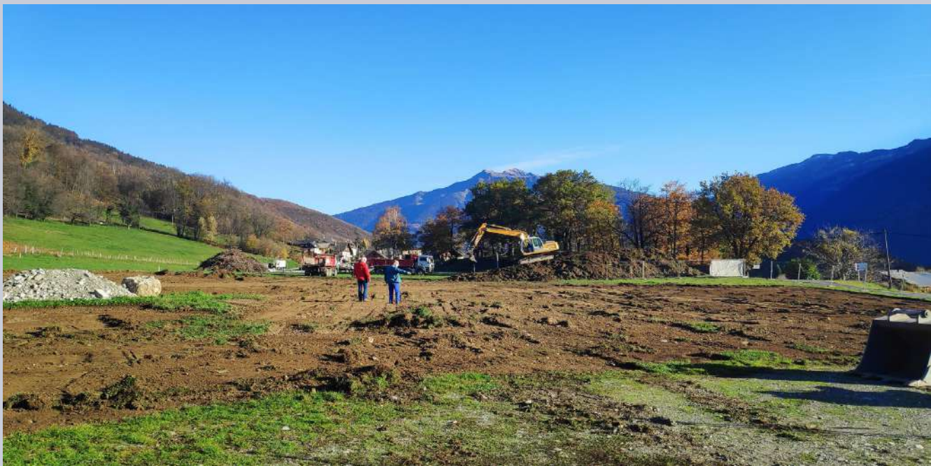
Début des travaux au mois de novembre 2020 : terrassement
